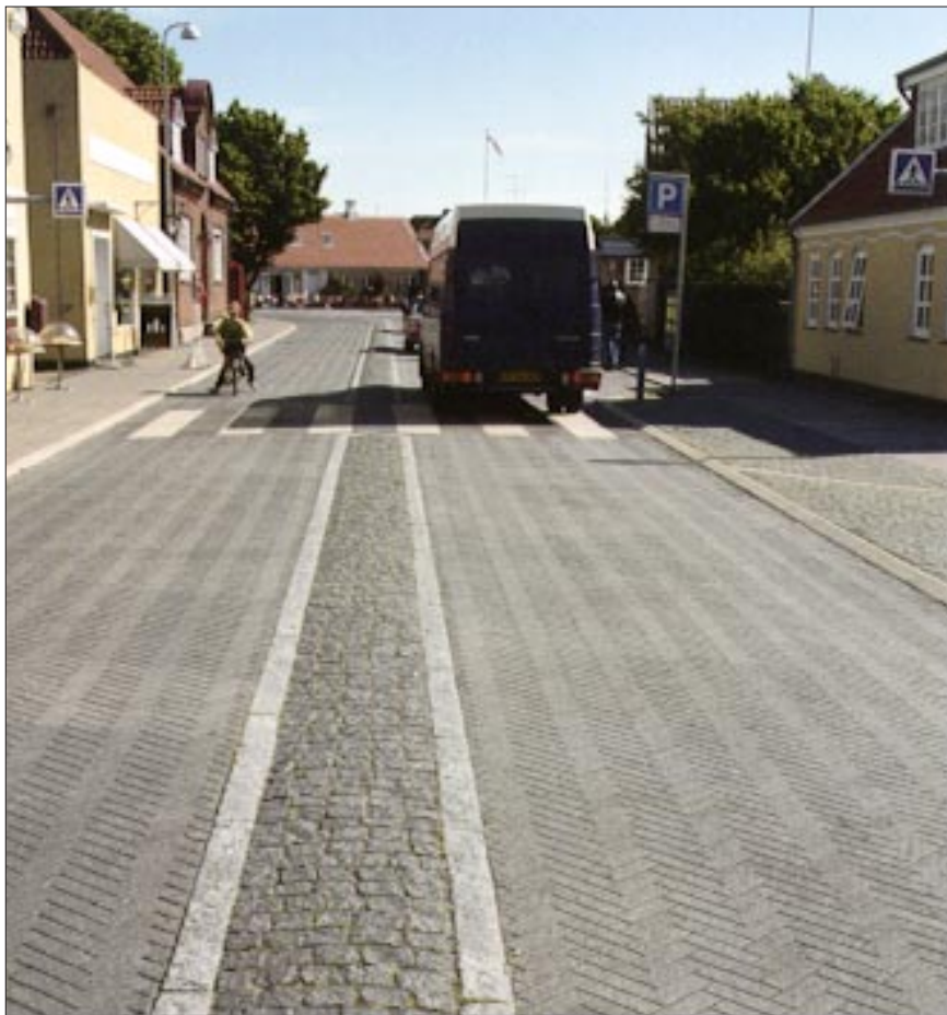
Hovedtrafikåre i Skagen. Trafikintensitet: ca. 12.000 biler pr. døgn (julumåned), årsdøgntrafik ca. 7.000. Vejbelægning: belægningssten lagt i sildebensmønster. Etableret i 1994. Vejen er i meget god stand på trods af, at trafikken tvinges til at køre i én bestemt bane, pga. midterrabatten.
